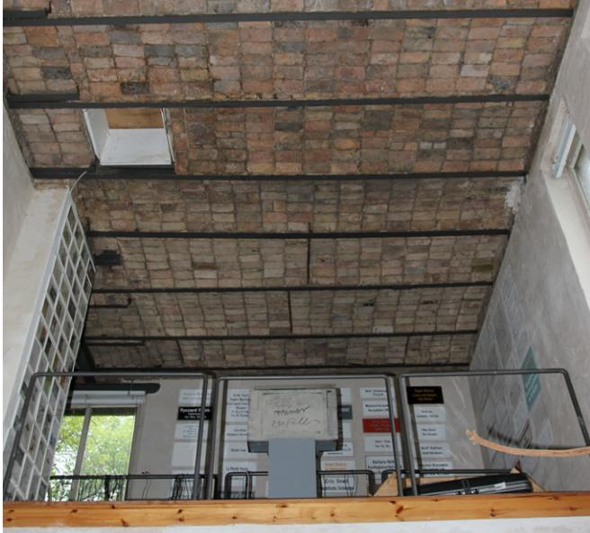
Die Deckenkonstruktion „Preußische Kappe“.
